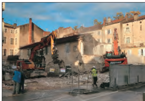
Démolition rue Victor Hugo à Cahors
