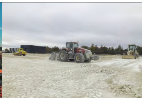
Traitement à la chaux au Sycala
