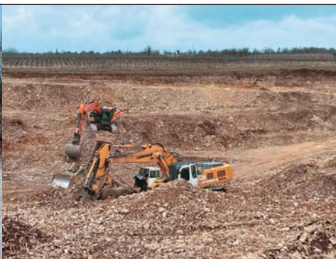
Réalisation d'un lac à Hautesserre
